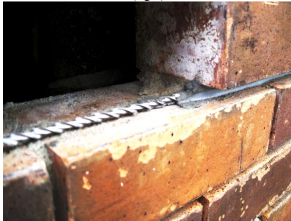
(d) closer view of NSM-TS bars
