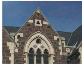
(d) Christchurch Arts Centre. Use of wall-diaphragm anchorages
