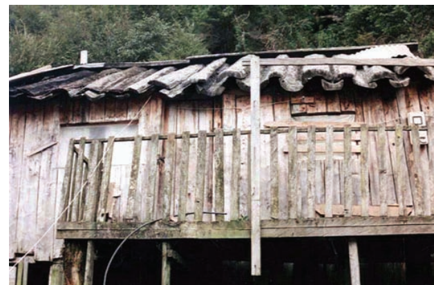
Figura 11: Casa con cubierta de "Canogas". Caleta Tortel, Undécima región de Aysén. Imagen del autor. 2000
