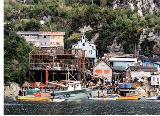
Figura 08: Caleta Lengua, ubicada en Puerto Gala (Isla Toto) en el año 2001. Nótese la presencia de viviendas de madera sobre pilotes. Del mismo modo se puede apreciar la Iglesia y el pabellón correspondiente a la escuela del sector. Imagen de la fundación Antonio Ronchi. 2010
