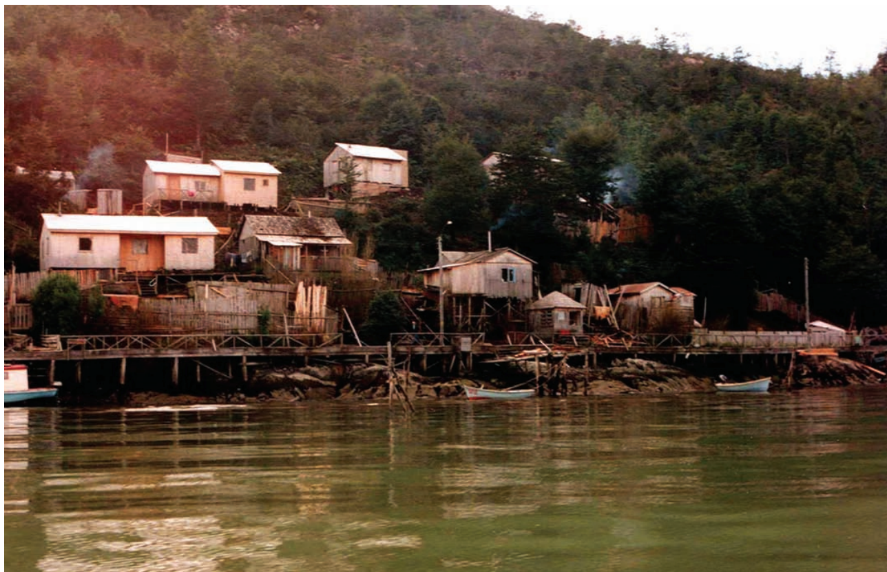
Figura 09: Caleta Tortel en la Undécima Región. Se pueden apreciar las pasarelas de madera en el borde, sobre las rocas y el agua, así como las viviendas sobre pilotes y algunos maderos acopiados en la orilla. Imagen del autor. 2000
